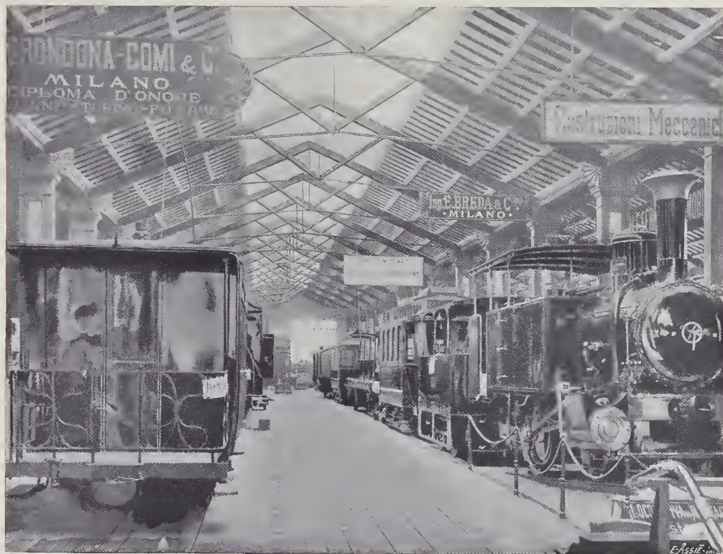
GALLERIA DELLE MACCHINE DI LOCOMOZIONE (Fot. Fratelli LOVAZZANO).
